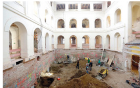
2019: Bauarbeiten im Lichthof
