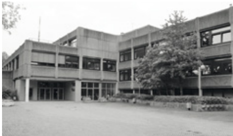
Gymnasium Neustadt an der Waldnaab vor der Sanierung
