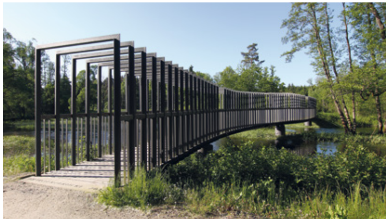
2010: Heusterzbrücke in den Waldnaabauen
