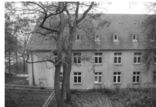
2018: Bestandsgebäude vor der Sanierung.
