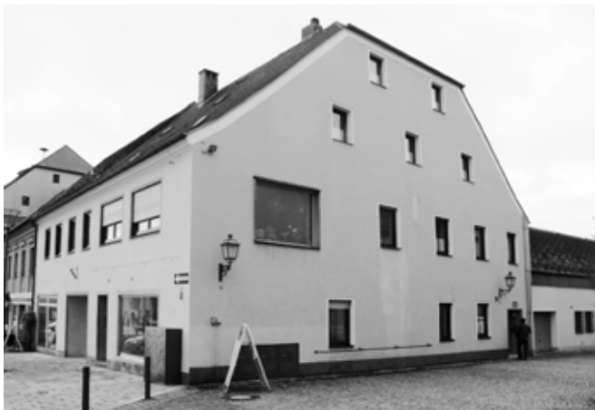
Bestandsgebäude vor der Sanierung
