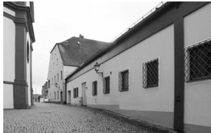
Bestandsgebäude vor der Sanierung
