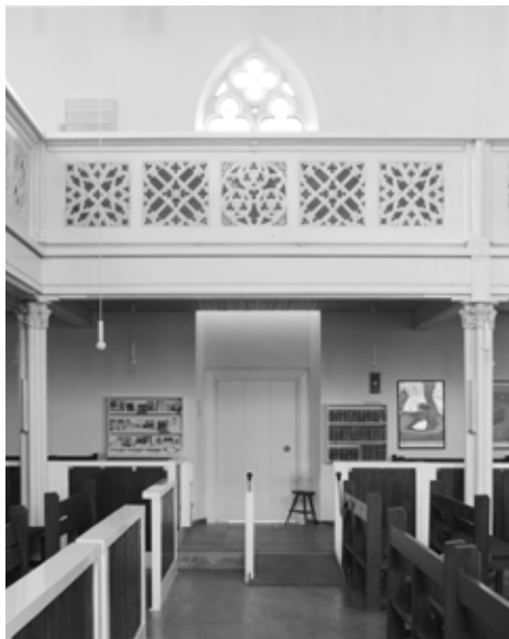
Die Schwelle am Eingang Nord konnte durch Senkung des Bodenniveaus barrierefrei gestaltet werden
