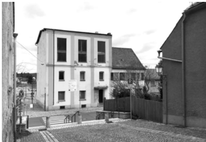
Bestandsgebäude der Brauerei Schels vor der Sanierung
