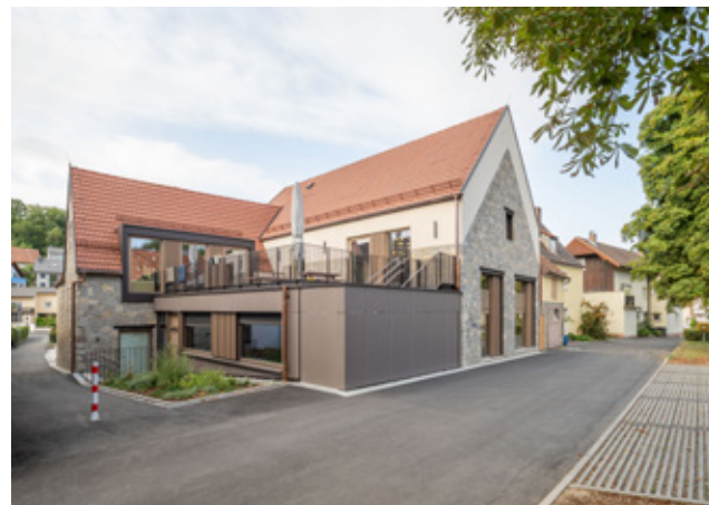
Weiterentwicklung des Bestandsgebäudes zur Kindertagesstätte nach der Sanierung
