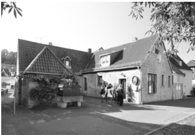
Bestandsgebäude des Marienheims vor der Sanierung
